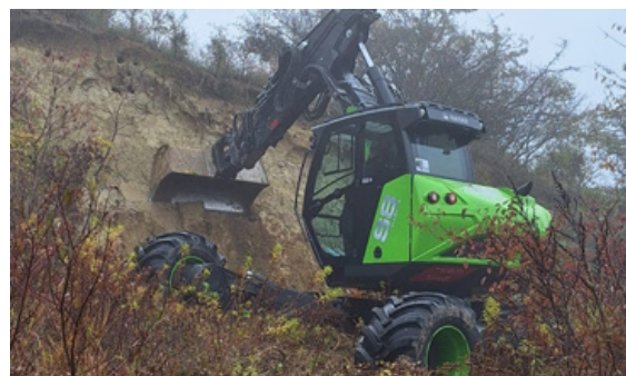
Ein steiler Geländeabriss an einer Bienenfresserwand wird hier mittels Schreitbagger wiederhergestellt.
