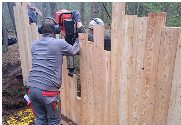
Beim Setzen der Moor-Spundwände sind Erfahrung und handwerkliches Geschick gefragt.
