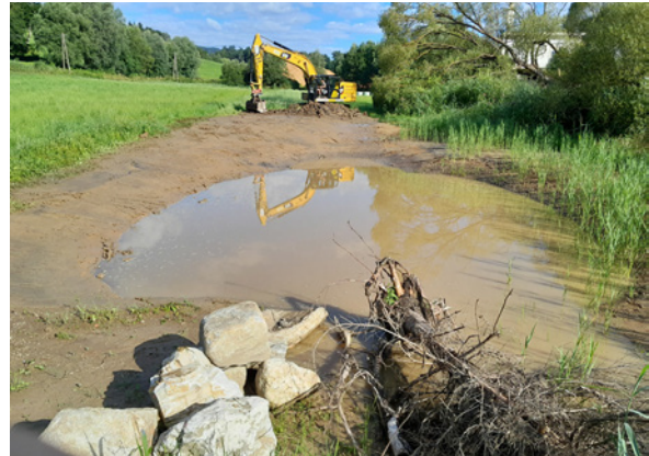
Errichtung eines Tümpels der von Grundwasser gespeist wird.
