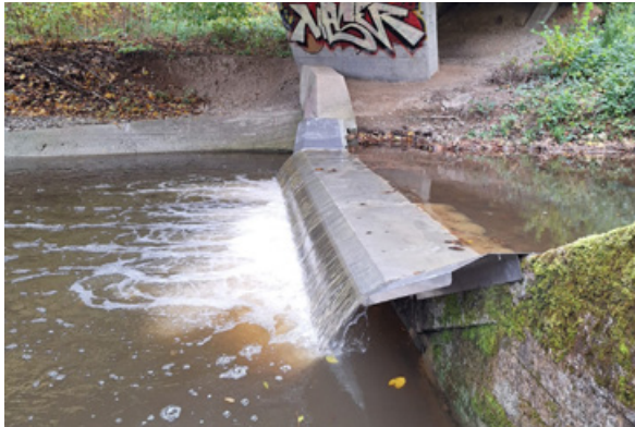
Bei einem bestehenden Querbauwerk in Schörfling wurde eine Krebssperre montiert.
