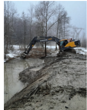
Bei den Arbeiten ist zuerst die Festigkeit des Untergrundes zu prüfen (oben links). Die ausgebagerten Flächen können sich schnell mit Wasser füllen (oben). Der Abtransport des Aushubs per LKW bringt erhebliche Mehrkosten (links).
