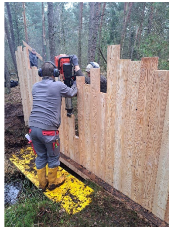
Einbau einer Spundwand
