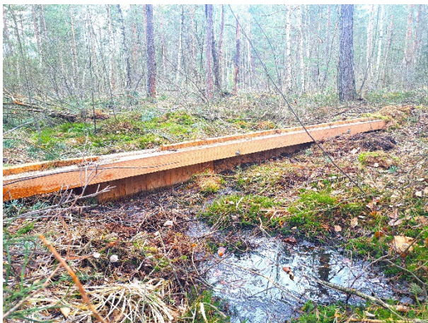
Spundwände dienen der Abdichtung, verhindern also den Wasserablauf © Thomas Kainz | Download (7,3 MB)
