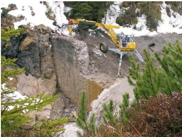
*Hornbach 2003 und 2005: Sperrenabtragung in zwei Stufen (Foto: Land Tirol)*
