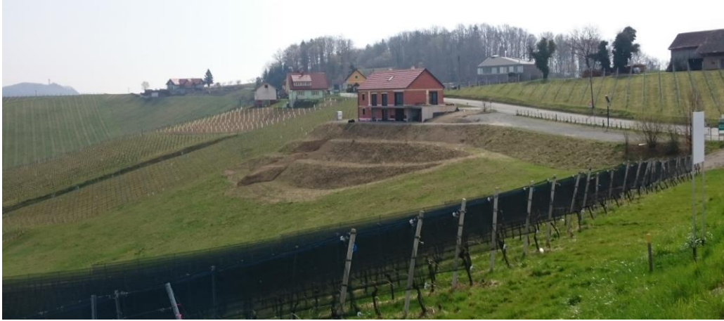
Abbildung 55: Geländeeinschnitte und Hagelnetze im Frühjahr, Ratsch/Ehrenhausen a.d.W.
