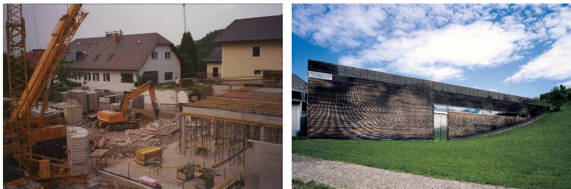
Abbildung 33: Weingut Lackner Tinnacher, Bau des Weinkellers und fertiger Keller
