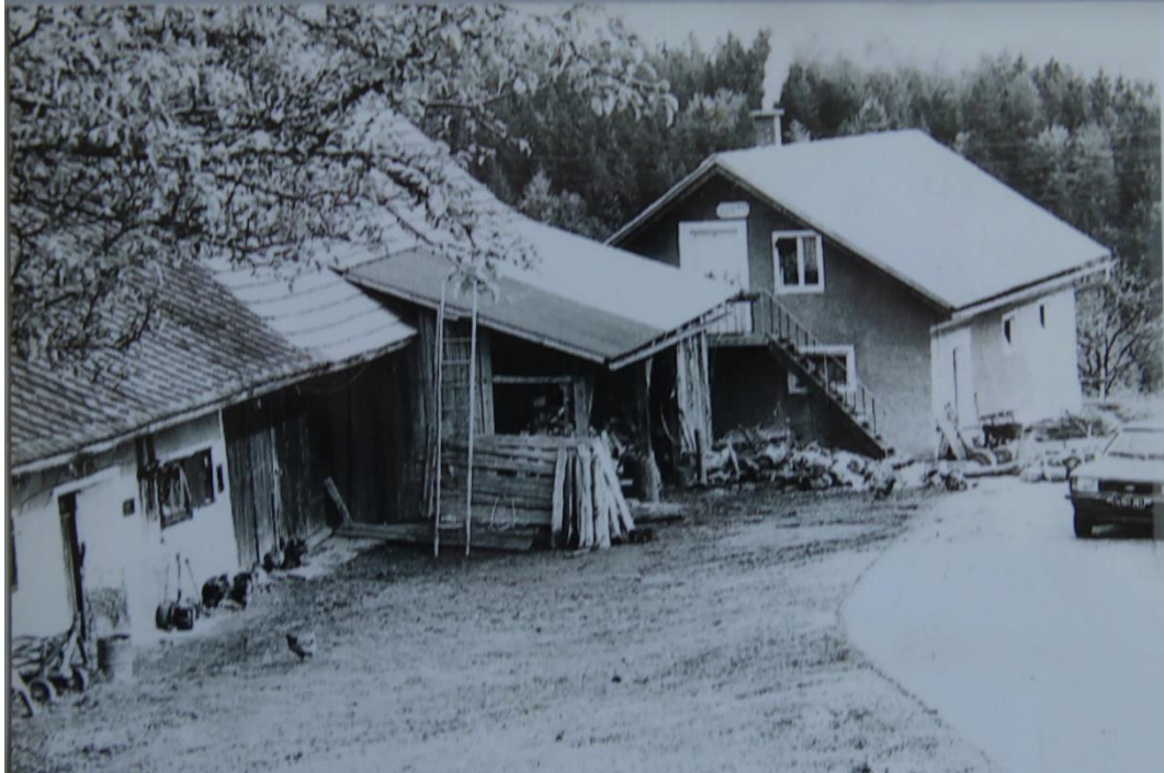
Abbildung 85: Serschenhof Tertinjek, Stallgebäude
