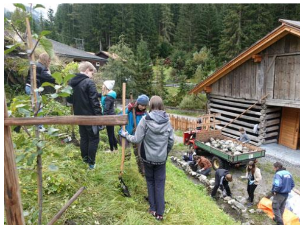
Errichtung der Legesteinmauer bei der Mühle, Foto: Archiv Naturpark Kaunergrat
